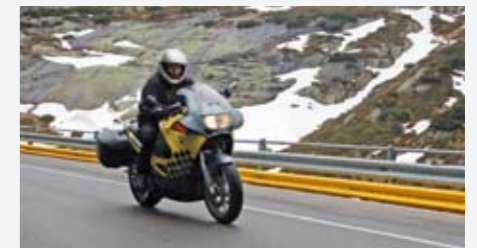
Unterfahrschutz am Grimselpass.
